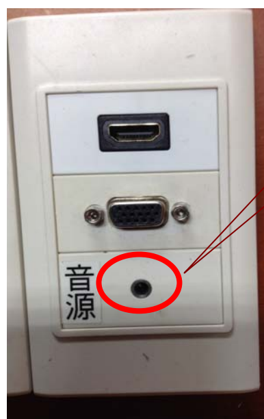
圖 4 NB 外接音源 線連接
